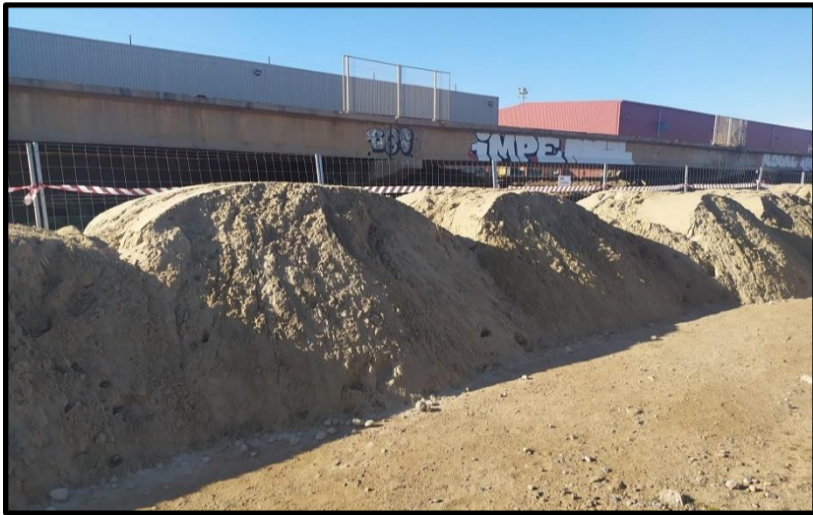
Movimiento de tierras en la obra terrestre del Pantalán
