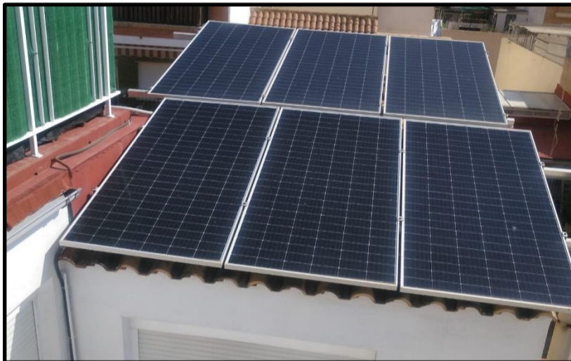
Instalación de placas fotovoltaicas en una vivienda de El Puerto
