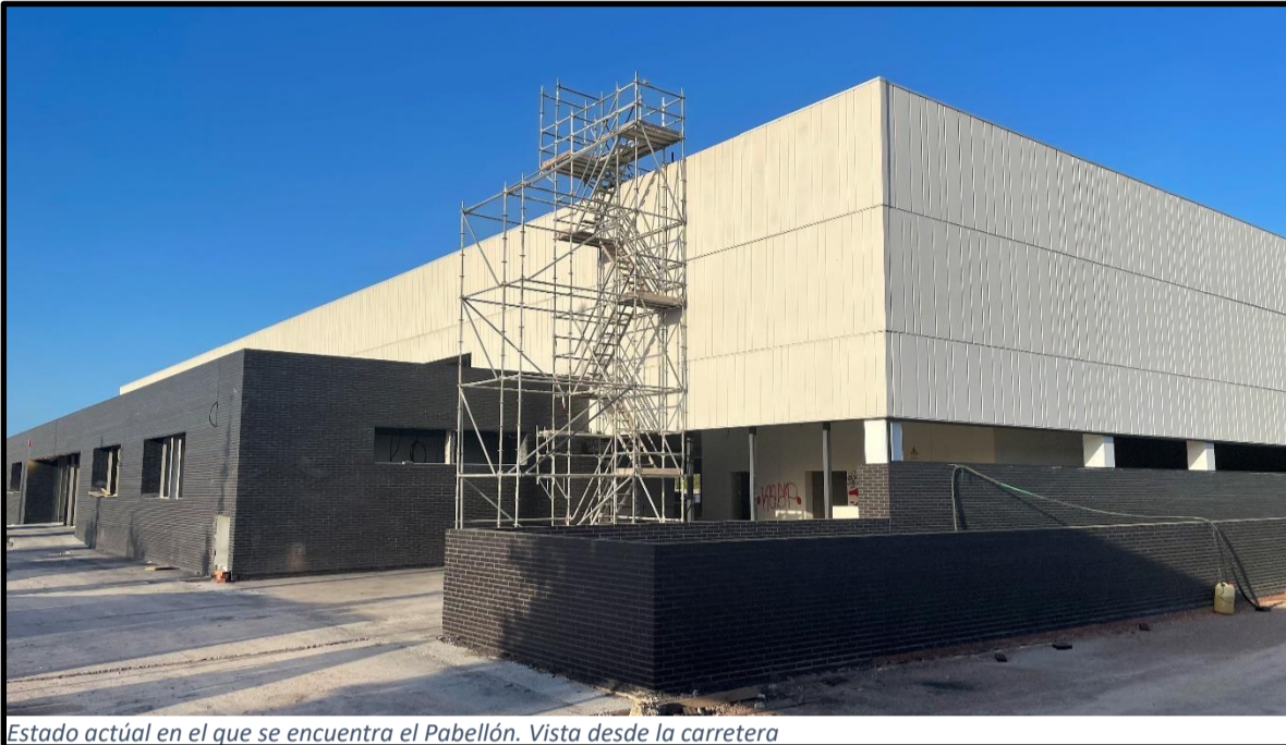
Estado actual en el que se encuentra el Pabellón. Vista desde la carretera
