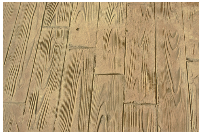
Hormigón impreso “madera”
