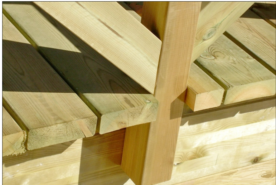
Detalle constructivo de la pasarela
