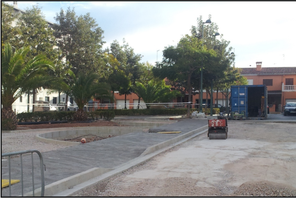
Estado de las obras en el barrio de San José
